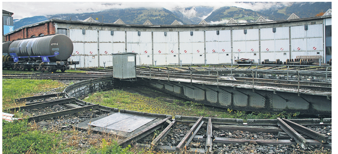
Drehscheibe und Lokremise Sargans: 1908 entstand die Ringsegmentremise mit 15 Lokomotivständen. Sie ist heute die grösste mit Gleisen erhaltene derartige Anlage auf dem SBB-Netz. Hans-Peter Bärtschis Bild stammt von 2011.
