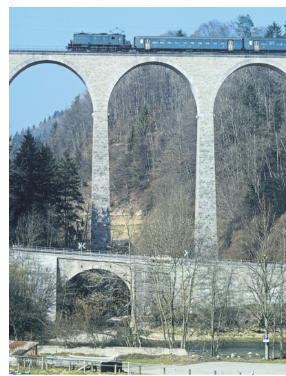
Guggenloch-Viadukt: Strassen- und Bahnbrücke über den Gonzenbach im Toggenburg. Aufnahme von Hans-Peter Bärtschi aus dem Jahr 1981.
